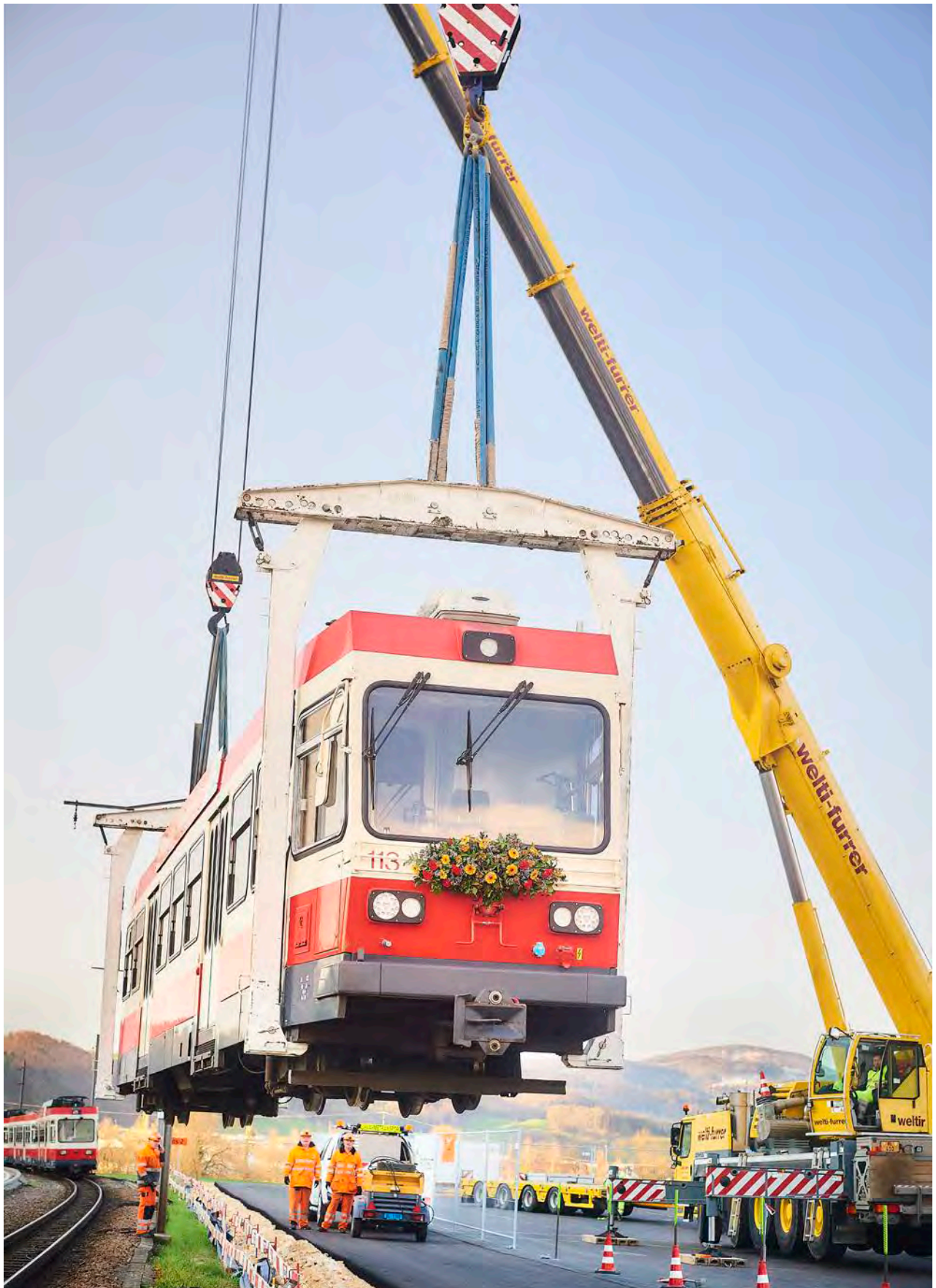
Die Schindlerwagen der Waldenburgerbahn werden «ausgeleist» und nach Cierny Balog transportiert.
