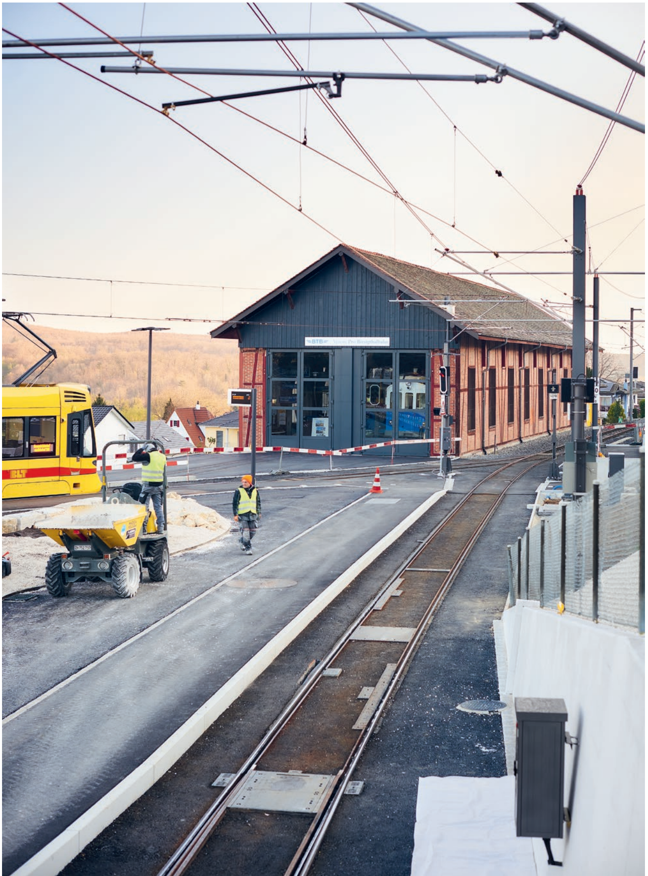
Die Remise in Rodersdorf präsentiert sich in neuem Kleid und ab Mitte 2023 inklusive Photovoltaikanlage auf dem Dach.
