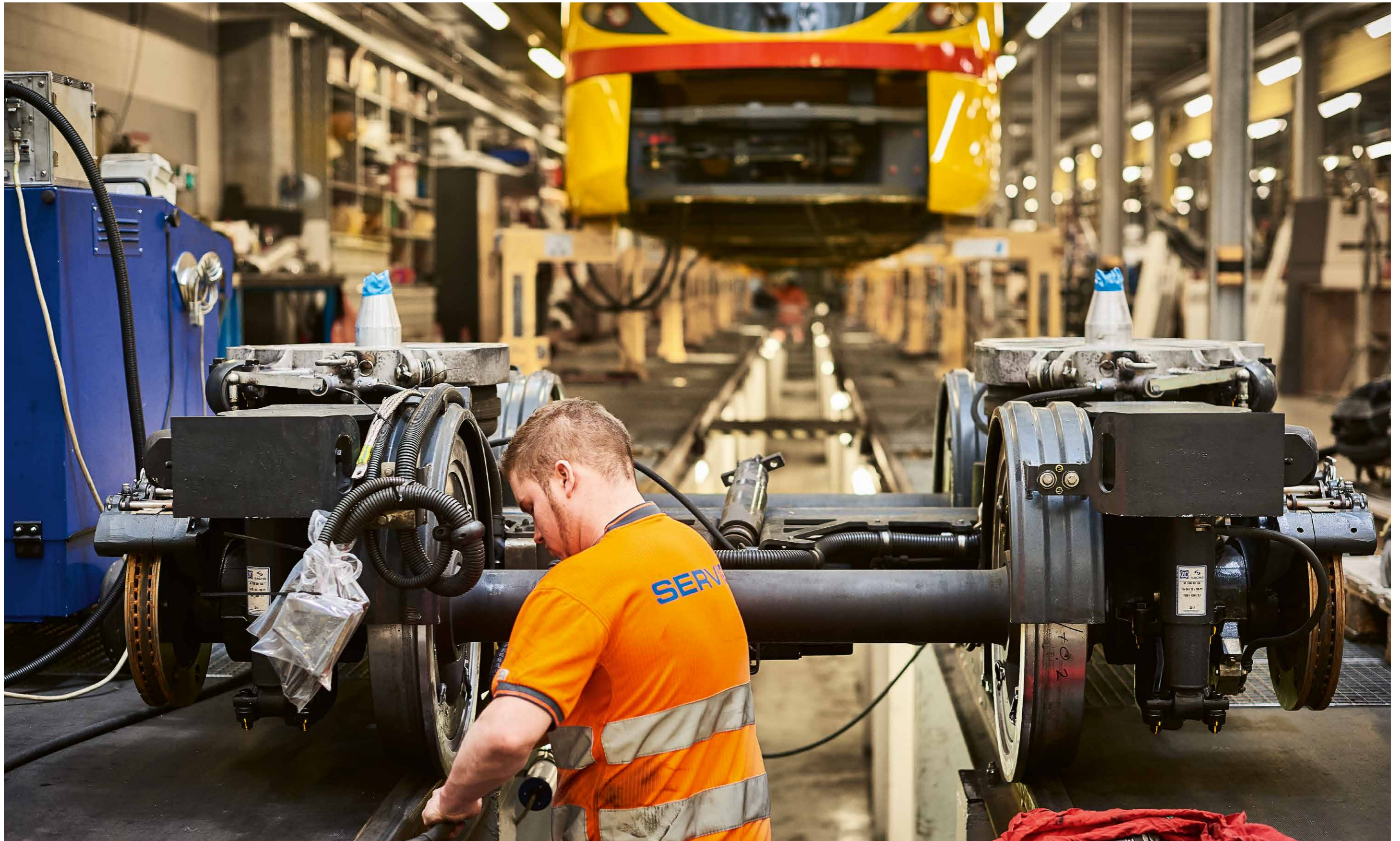
Blick in die Wartungshalle des Tramdepots Hüslimatt.
