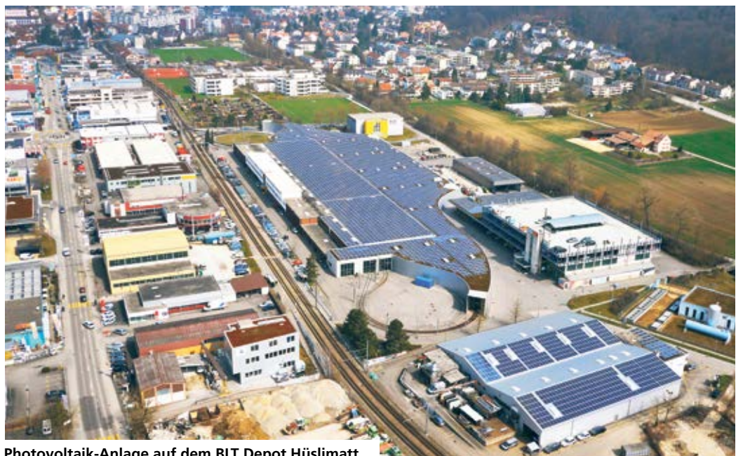
Photovoltaik-Anlage auf dem BLT Depot Hüslimatt.
