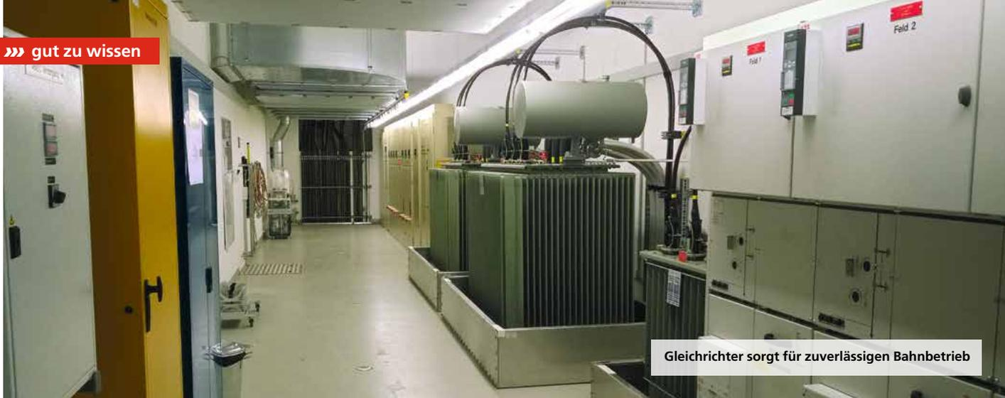
Gleichrichter sorgt für zuverlässigen Bahnbetrieb
